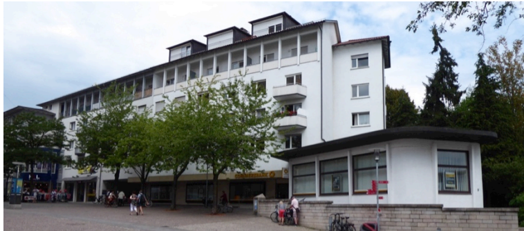
Ehem. Hotel „Sonne“ an der Friedrichstraße
