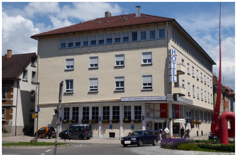
Hotel „Goldener Hirsch“ an der Charlottenstraße
